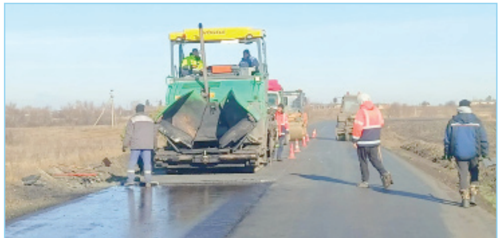
📹 Завершается капитальный ремонт дороги Шемышейка-Кондоль в границах Шемышейского района. Дорожники укладывают второй слой асфальта.
