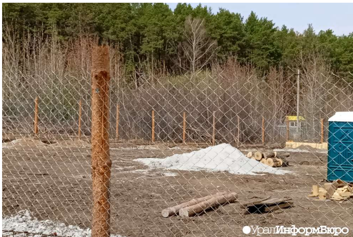
Стройплощадка нового коттеджа на улице Изоплитной
