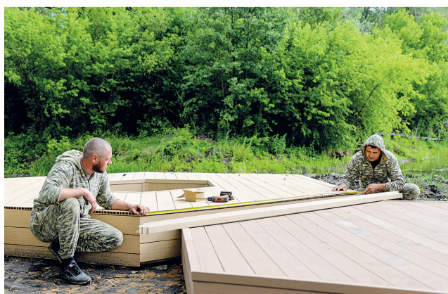
Рабочие укладывают деревянные соты
