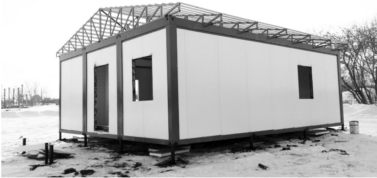
В д. Камышевке строится модульный ФАП. Сюда в этом году переедут местные медики, получив комфортные условия для работы. А камышевцам больше не придется преодолевать длинную дорогу, чтобы получить медицинскую помощь. Фото РИММЫ ХИБАТУЛЛИНОЙ.
