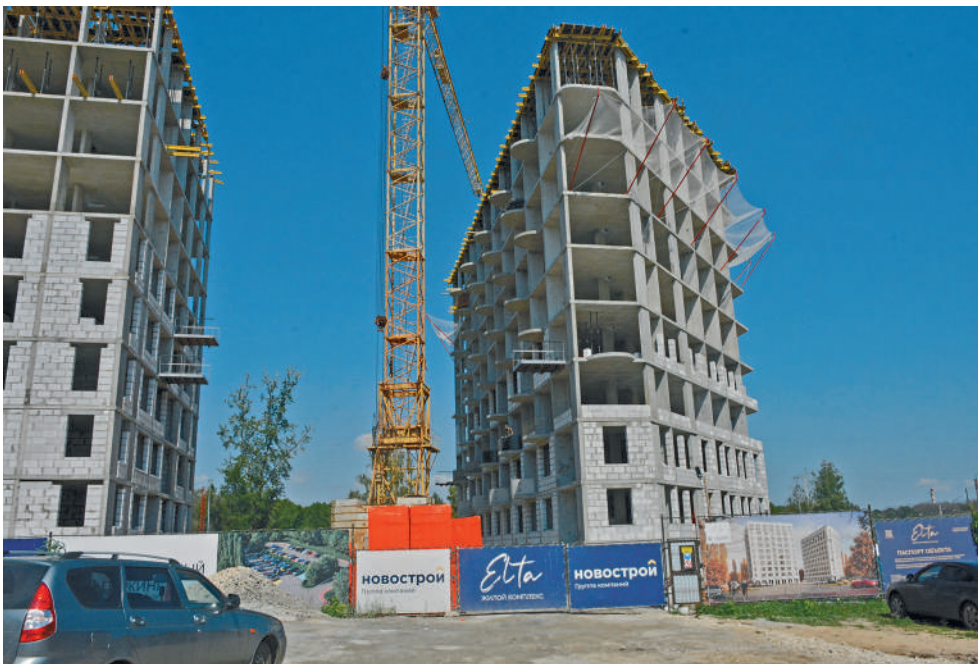
Строительство идет полным ходом.
