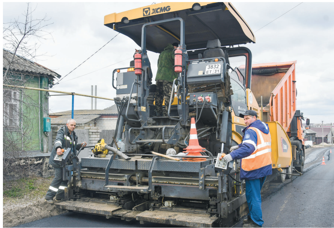
Работает асфальтоукладчик
