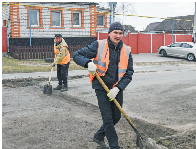
Подготовка полотна к укладке асфальта
