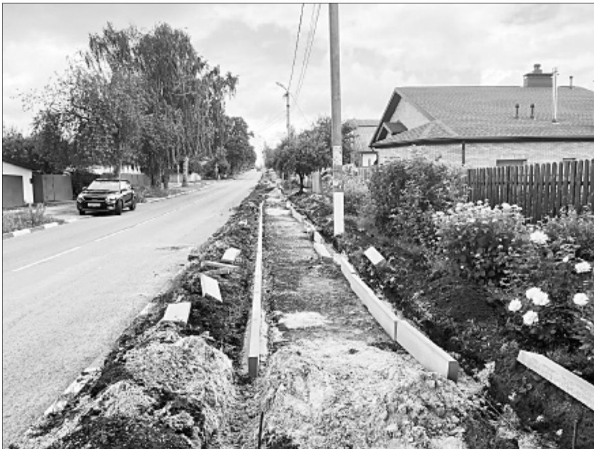
Вот в таком виде предстал перед нами строящийся тротуар 14 июня с.г. / ФОТО: Р. ОЖЕГОВ
