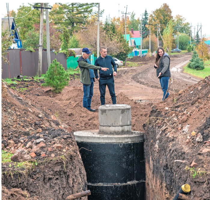
Здесь установят пожарные гидранты — на случай возгораний.
