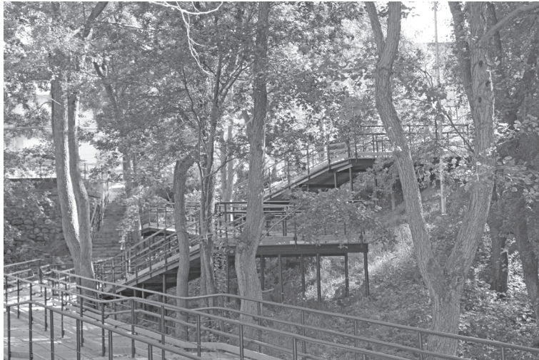
В зону отдыха в овраге с ул. Флотской ведёт лестница и пандус для маломобильных граждан. Отметим, что для спуска в овраг оборудованы пандусы ещё в двух местах: от улицы Пограничной и из городского парка
