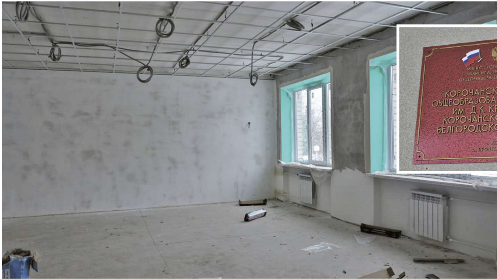
После ремонта внутренний облик помещения изменится до неузнаваемости
