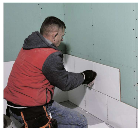
Строители приступили к отделочным работам
