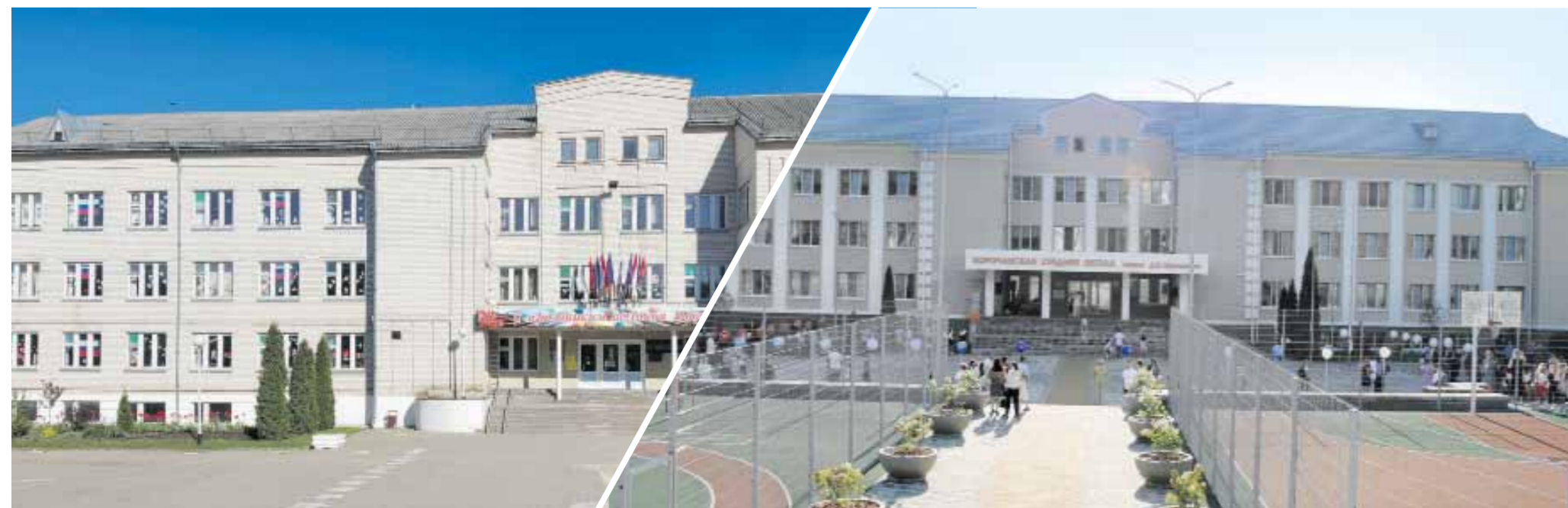
Фасад школы до ремонта
