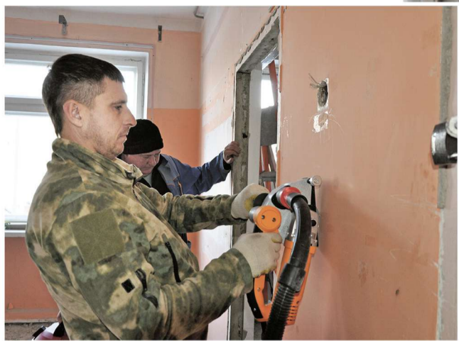
Строители приступили к монтажу электропроводки
