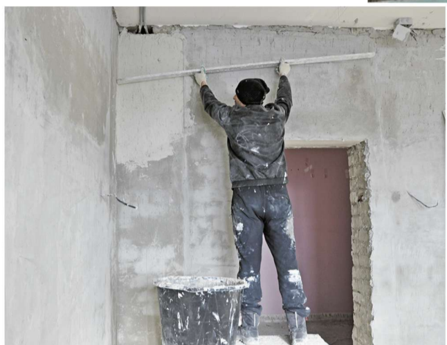
В некоторых классах уже штукатурят стены
