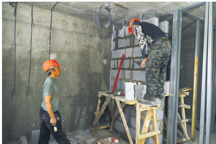
Строители в одной из квартир работают над устройством вентиляционной шахты. В помещении тепло, уже разведена электропроводка, вставлены окна. Впереди — монтаж трубопроводов и многое другое
