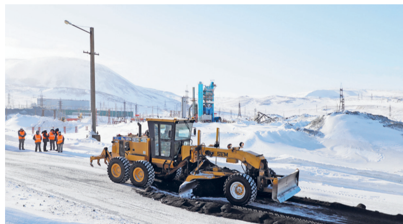
Равномерное распределение посыпки — наиболее эффективный способ борьбы с гололёдом
