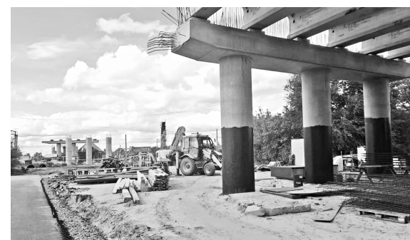
проведено расширение проезжей части.
