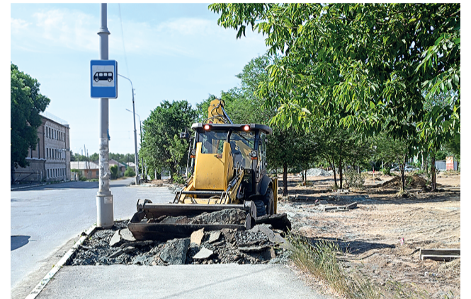
Вдоль тротуаров демонтирован старый бордюрный камень и асфальтовое покрытие
