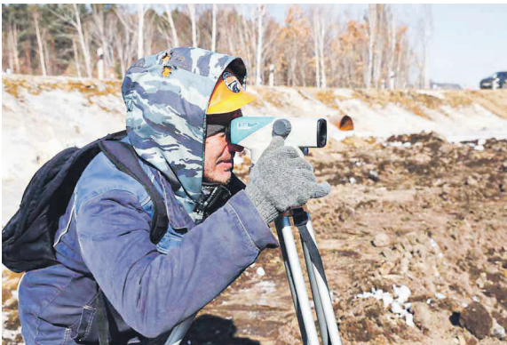
Подрядчику предстоит полностью переустроить сотни километров инженерных коммуникаций: линий электропередачи, теплосетей, водопровода и канализации.
