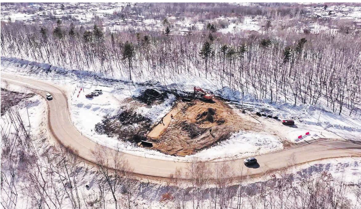
Работы по реконструкции дороги идут с опережением графика.
