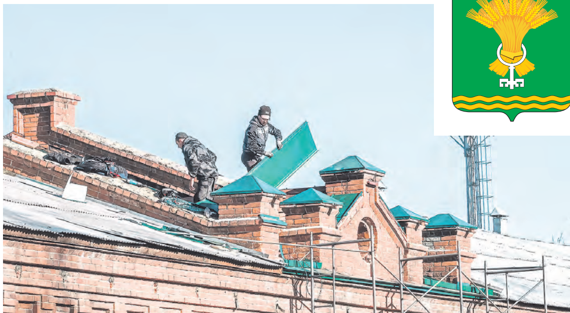
В спиртовом цехе старинного Биохимического завода приступили к обшивке крыши
