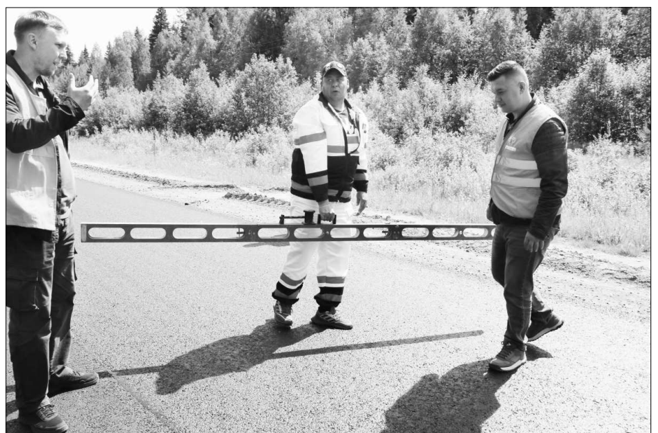
Проверка поперечного уклона.
