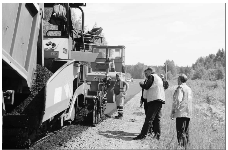
Работа асфальтоукладчика.
