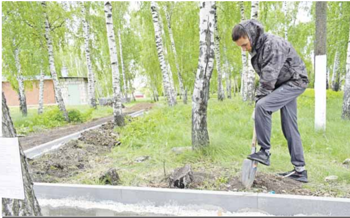
Тротуары строители оформляют бордюром камнем
