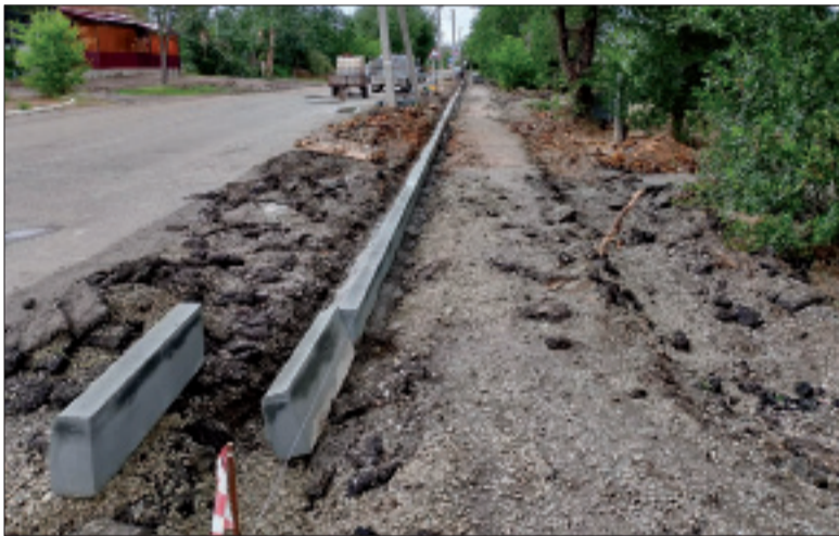
Устройство тротуара по ул. Торговой
