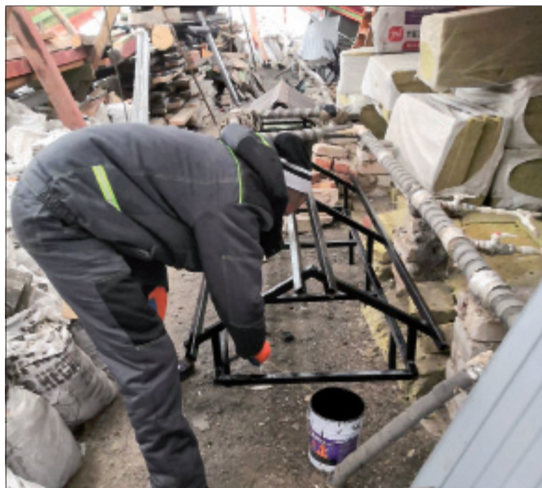
Производится покраска каркаса конструкции, которая будет защищать вентиляционные трубы от повреждений и попадания атмосферных осадков
