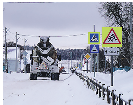
Установлены дорожные знаки в д. Такагурт./ Фото Ирины Перевозчиковой
