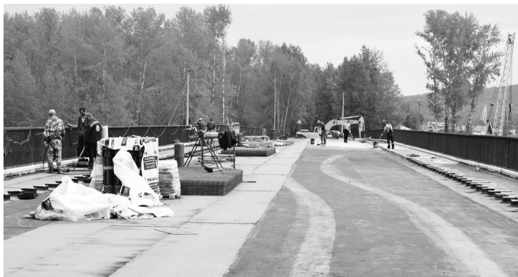
Близится к завершению реконструкция моста через протоку Куты
