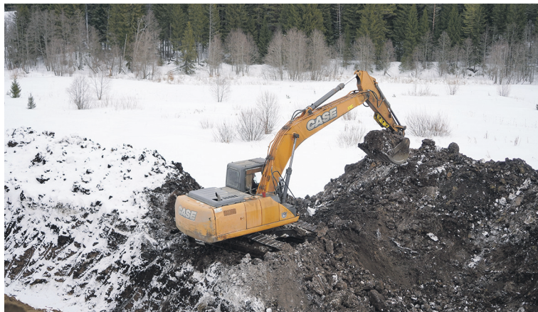
Экскаватор расширяет площадку для хранения материалов дорожного полотна./ Фотографии Ирины Перевозчиковой
