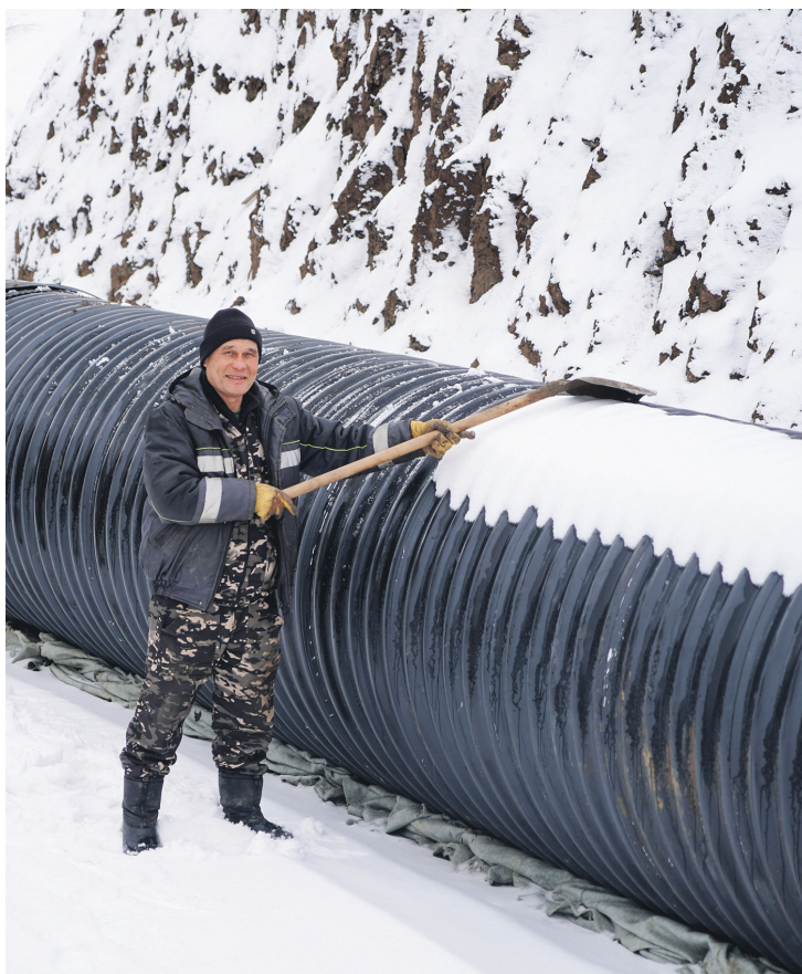
Работник ООО «Риол» Фахриддин Примкулов расчищает гофрированную металлическую трубу для пропуска воды.
