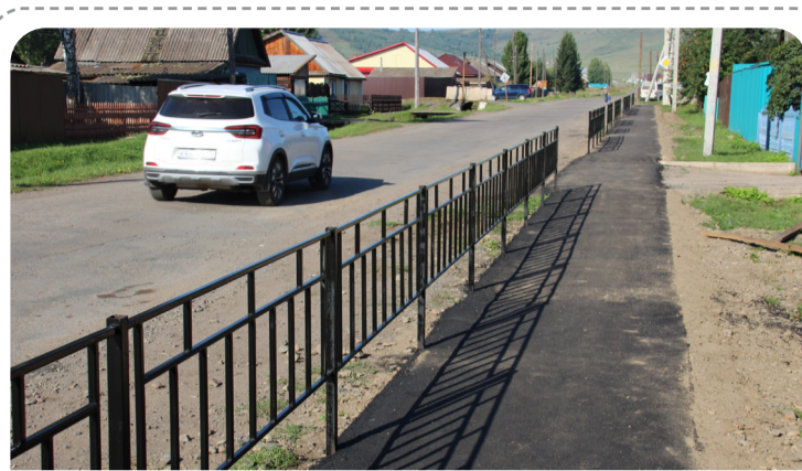
Первая очередь пешеходной дорожки по ул. Вокзальной была построена 2 года назад. А в этом году и в следующем будут построены вторая и третья очередь, уже без металлического ограждения, но с обязательным обустройством бордюров. И тогда новый тротуар «вырисуется» по всей длине этой улицы.
