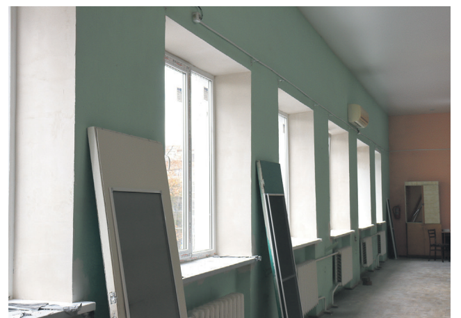
На сегодня строительная готовность объекта составляет уже 80%
